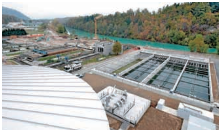
Največja infrastrukturna projekta zadnjih štiridesetih let v kranjski občini, projekt Gorki s čistilno napravo in vodovod Bašelj-Kranj, sta uspešno zaključena. / Foto: Gorazd Kavčič
