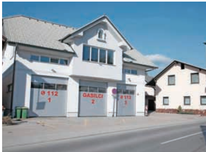
Na Zgornjem Brniku so odprli nov gasilski dom.
