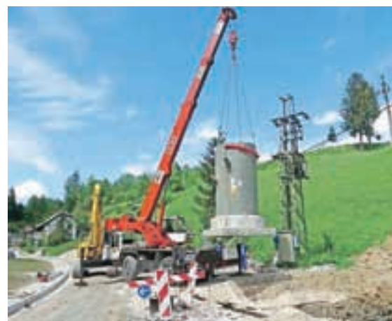
Gradnja kanalizacije v Tunjicah
